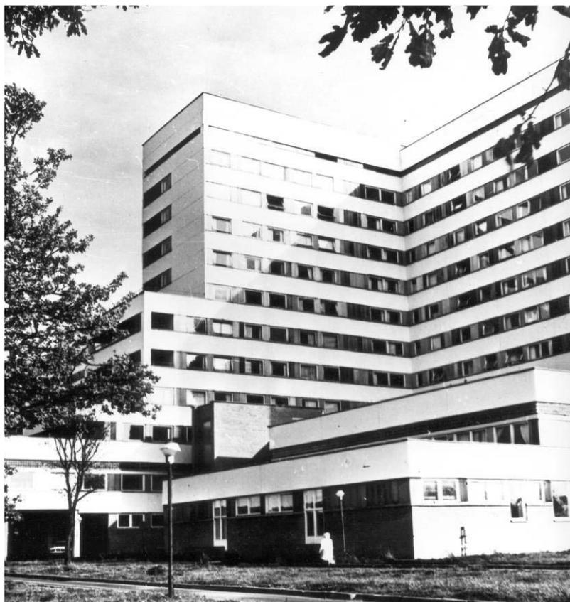
**Рисунок 1.26 – Больничный комплекс из газобетонных панелей, Рига**
