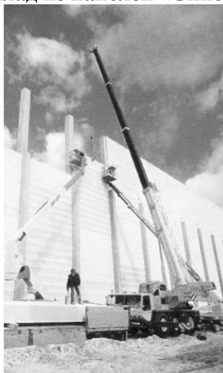
**Рисунок 1.22 – Возведение стен заводского цеха из стеновых панелей «Небел»**
