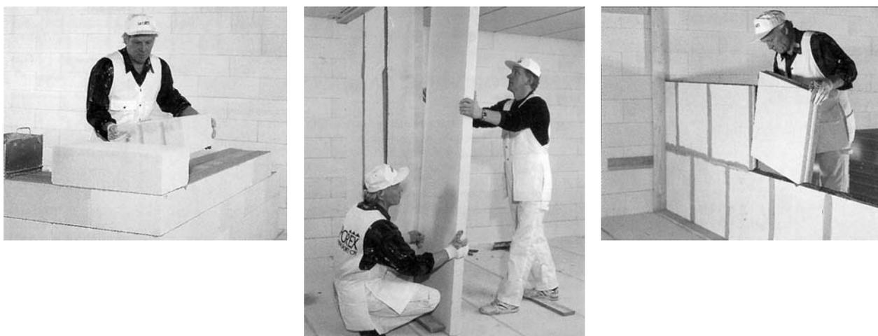
Рисунок 4.8.1 - Возведение газобетонных стен
