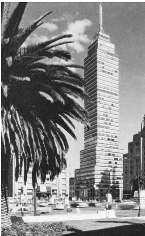
**Рисунок 1.15 - 43-этажный небоскреб со стенами и перекрытиями из «Сипорекса» в Мексике, выдержавший 8-бальное землетрясение**
