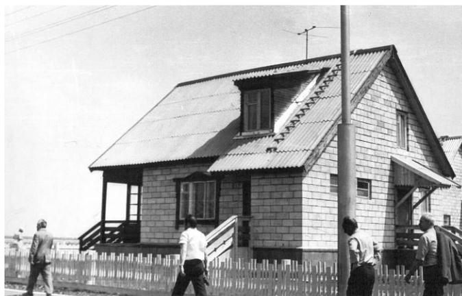
**Рисунок 1.7 – Мелкоблочный газобетонный дом с мансардой типовой серии 216 в Саратовской области.**
