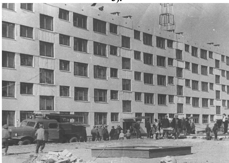
**Рисунок 1.3 – Цельногазобетонный дом – прототип общесоюзной серии 468АЯ, выстроенный в Павлодаре**
