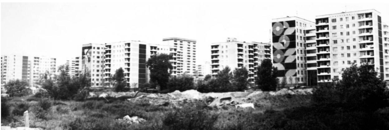
**Рисунок 1.10 - Панорама застройки Свердловска домами с газозобетонными наружными стенами на 2 окна, с отделкой дробленным камнем, производства завода «Им. Ленинского комсомола»**
