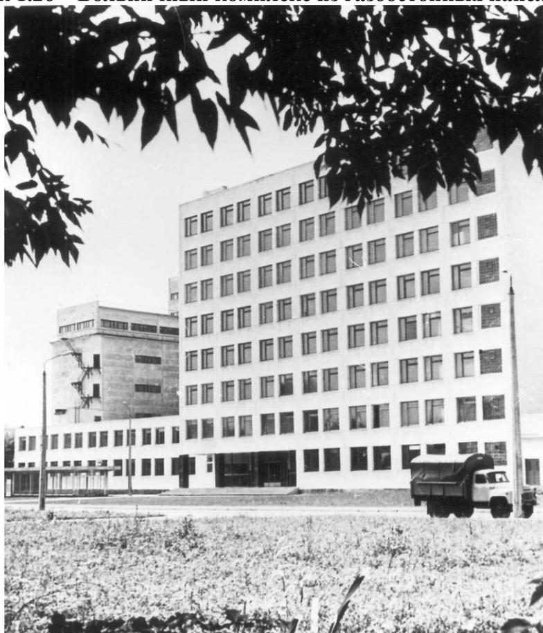
**Рисунок 1.27 – Производственное здание из газобетонных панелей, Украина**
