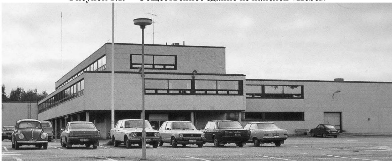
**Рисунок 1.20 – Заводское здание из панелей «Сипорекс», Финляндия**
