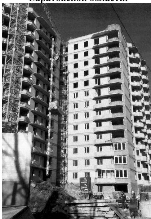
**Рисунок 1.8 – Многоэтажные дома, строящиеся в Санкт-Петербурге под рубрикой «кирпично-монолитных» с наружными стенами из мелких газобетонных блоков, опирающихся на перекрытия, с облицовкой в полкирпича.**
