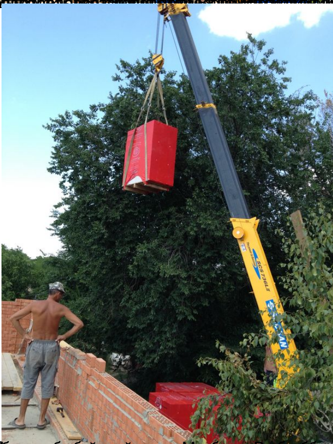
Крановые работы выполняются с помощью крана, который устанавливается на автомобильном шасси.
