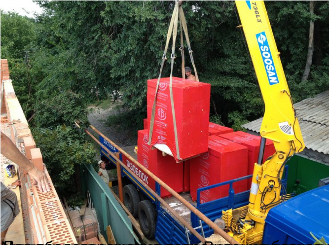
Длина бруса не превышает 10 метров, поэтому для перевозки требуется транспортное средство с грузоподъемностью не менее 10 тонн.
