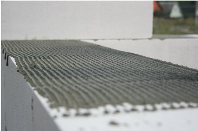
Наша компания предлагает своим клиентам клеевой раствор для блоков из газобетона. Клеевой раствор для блоков АЗОЛИТ-Кр позволяет производить однородную кладку и сводит теплопотери через стены постройки к минимальным.
