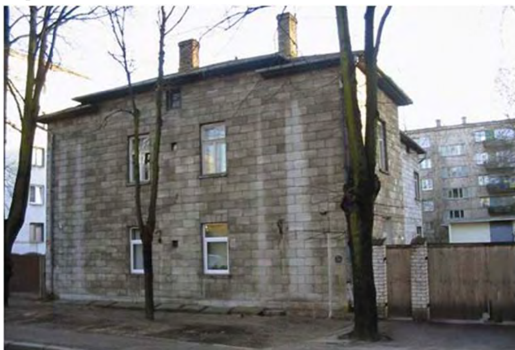
Рис. 1. Здание из автоклавного газобетона без наружной отделки. 1939 г.п., г. Рига, ул. Эльвирас, 15
